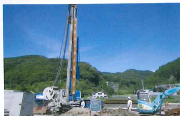
④鋼矢板吊り込み、取付状況
