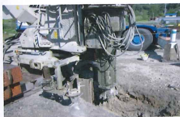
④鋼矢板吊り込み、取付状況
